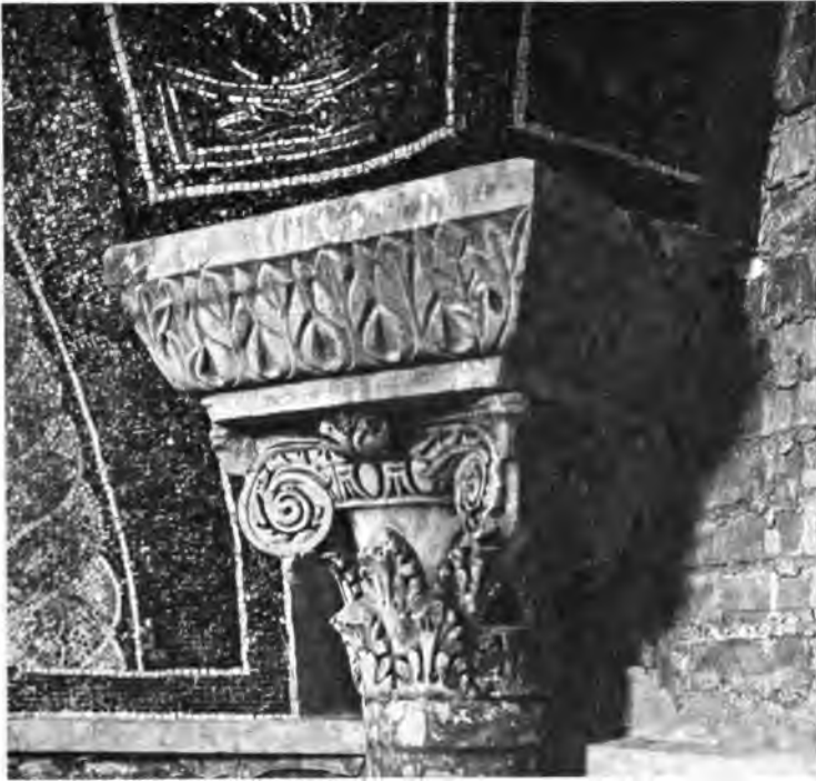
Fig. 33. — Chapiteau composite romain utilisé au v e siècle pour soutenir le sommier d'un arc revêtu de mosaïque au Baptistère des Orthodoxes de Ravenne. Introduction d'un nouvel élément de construction : le tailloir.
